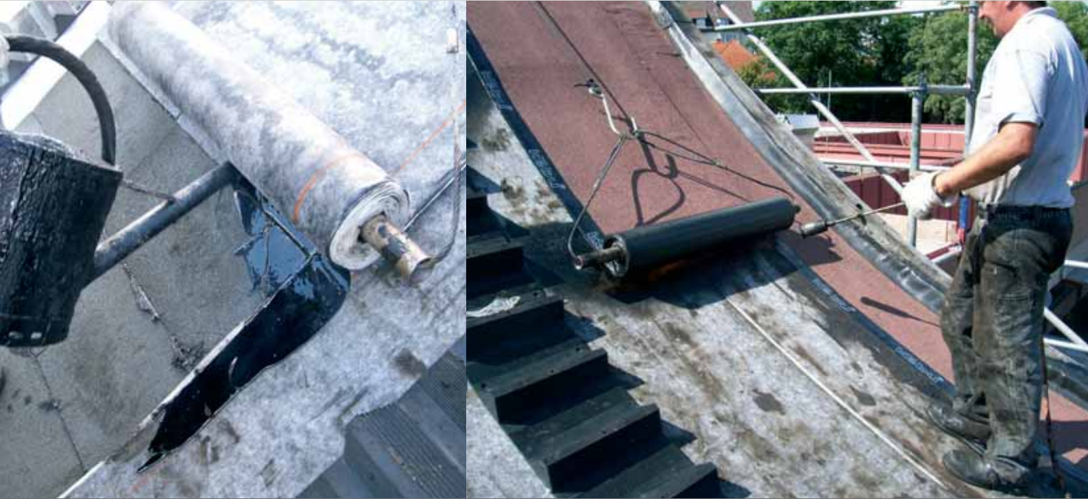
Sowohl das Verschweißen als auch die Verlegung in Bitumen wurde mit Hilfe einer besonderen Vorrichtung vorgenommen.
