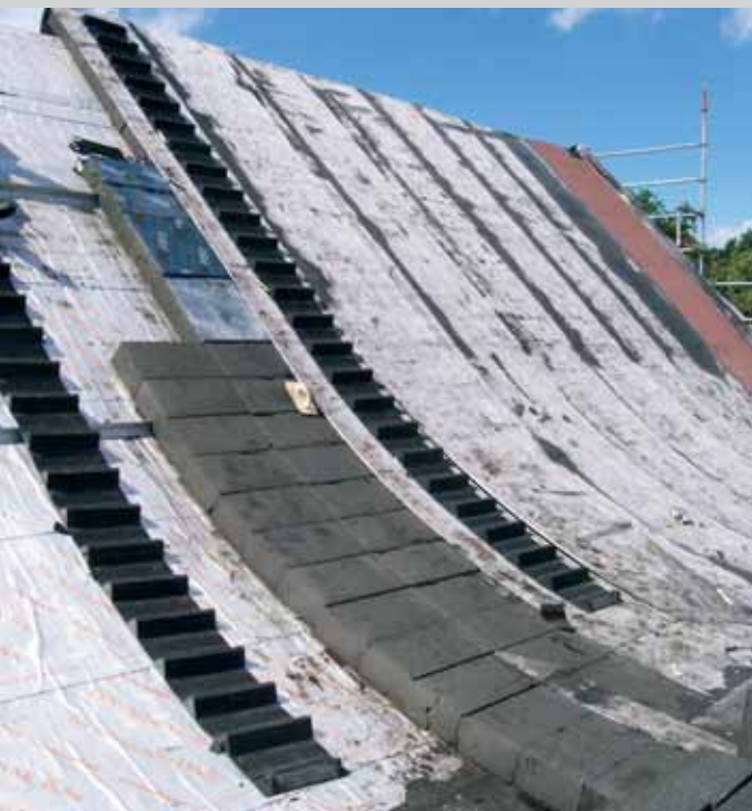
Als neue Wärmedämmung wurde Schaumglas eingesetzt.
